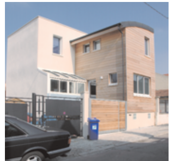
Sur le bâti ancien, l'extension est réalisée en bois.
