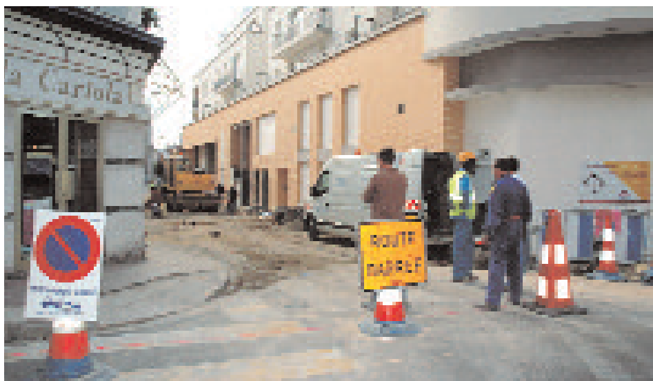
Réfection de la rue Salvador-Allende à l'achèvement de l'immeuble de logement sociaux
