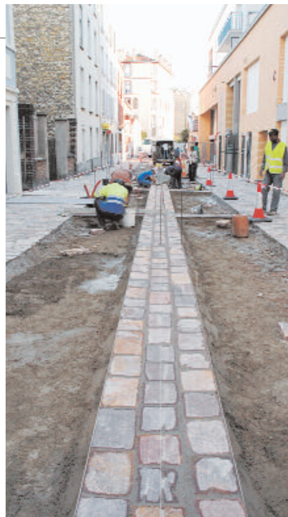
Une fois la ZAC finie, la voirie est totalement refaite. Après la rue Allende, ce sera le tour des rues Louis-Blanc et Béranger.
