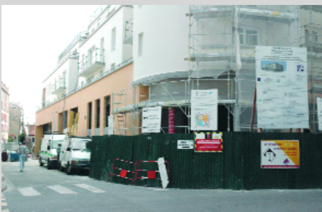
Logements locatifs et locaux commerciaux en phase de finition
